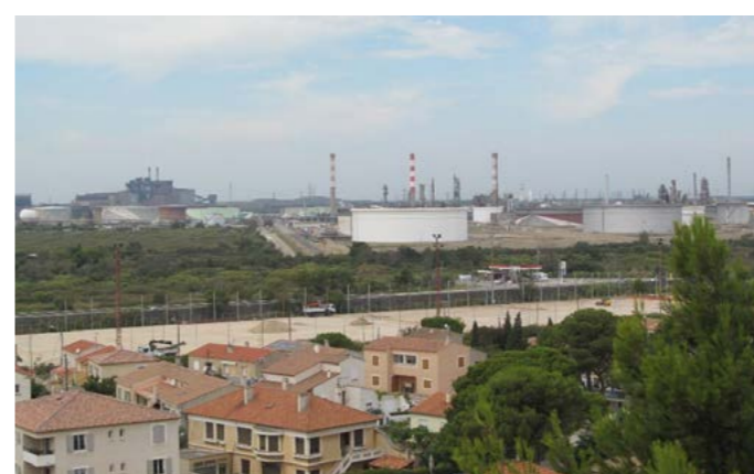
BIORAFFINERIE DE LA MÈDE MARTIGUES, FRANCE
